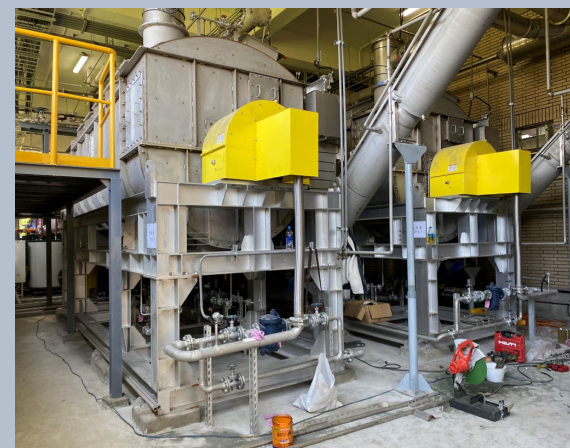
八里污水處理廠
